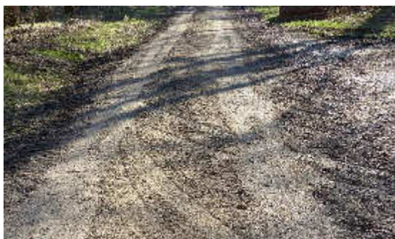
Abb. 36: Weg nach Befahren mit Bänder und abziehen mit Frontpolterschild
